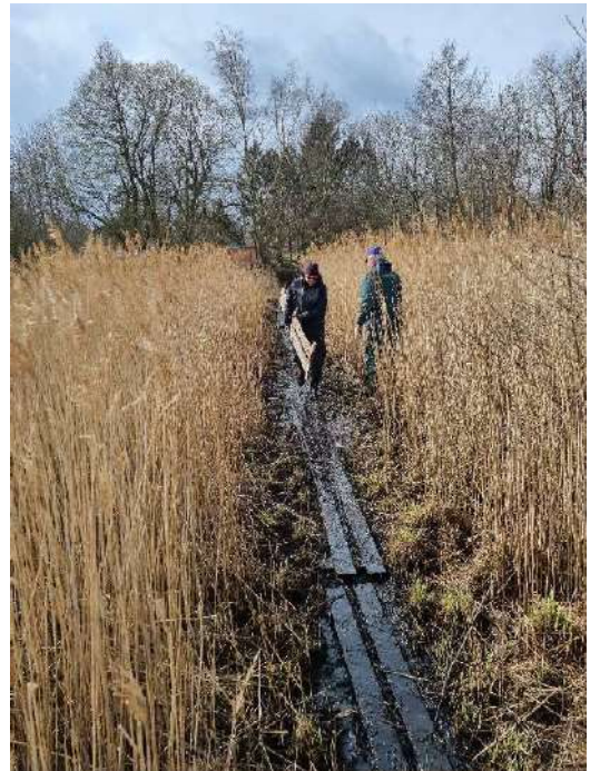
Udlægning af gangbrædder, april 2022.
